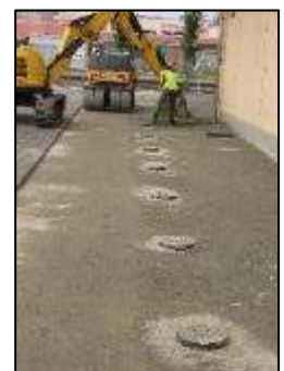
マンホールトイレの設置工事
